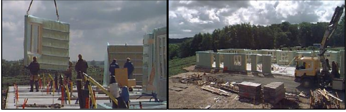
Şekil 11. Panel sistem bina inşaatı (Dubina, Ungureanu & Landolfo, 2012)
