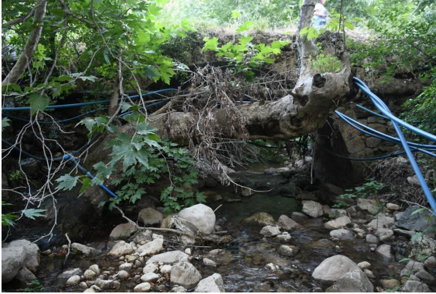
Şekil 8: Obruk Yolu Taş Köprüsü mansap cephesi görünümü
