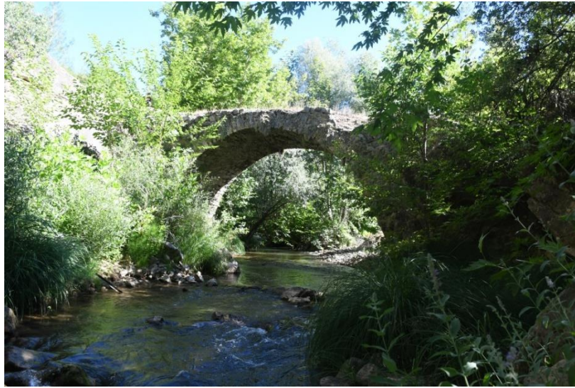
Şekil 2: Himmetli Köprüsü mansap cephesinden genel görünüm
