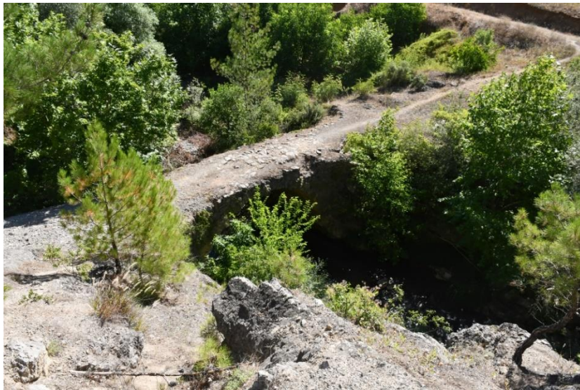
Şekil 1: Himmetli Köprüsü genel görünüm
