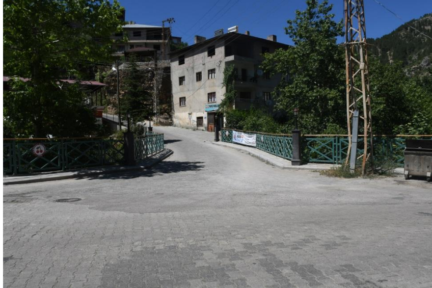
Şekil 5: İslam Mahallesi Taş Köprü genel görünüm
