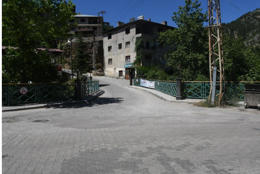
Şekil 5: İslam Mahallesi Taş Köprü genel görünüm
