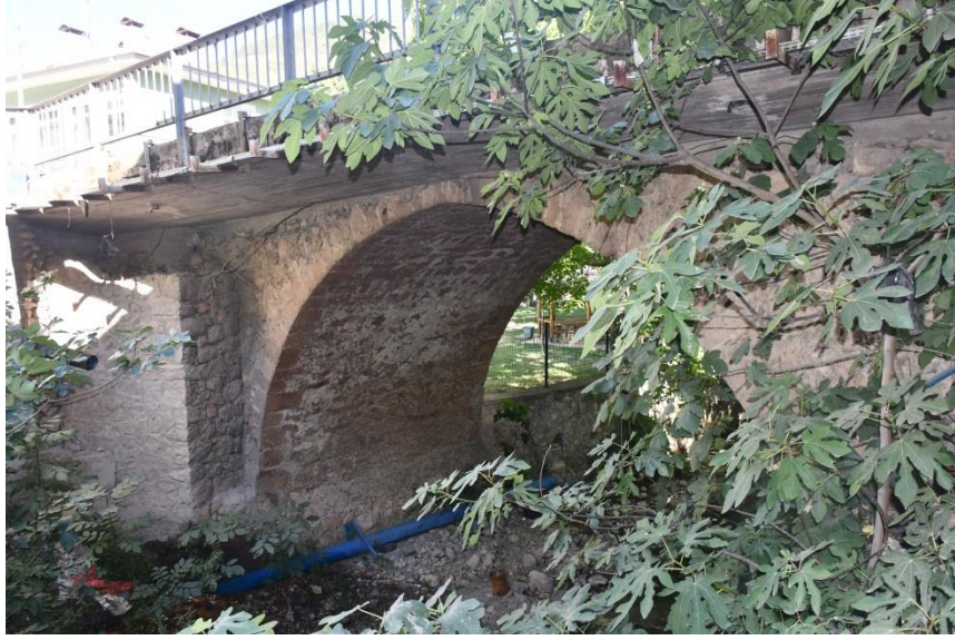
Şekil 3: Fatih Mahallesi Taş Köprüsü mansap cephesinden görünüm
