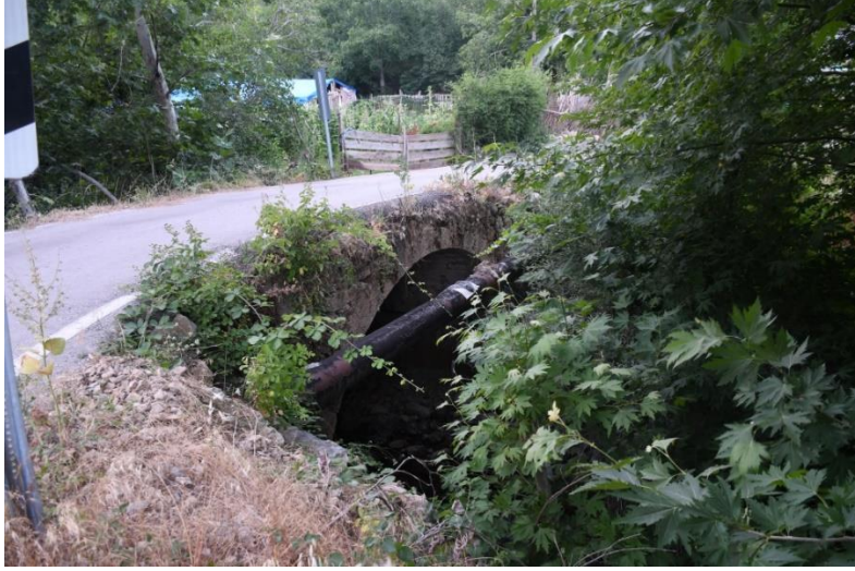
Şekil 7: Obruk Yolu Taş Köprüsü genel görünüm
