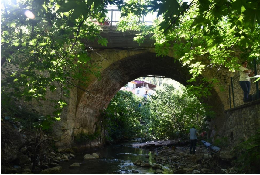
Şekil 3: Fatih Mahallesi Taş Köprü'sü mansap cephesinden genel görünüm
