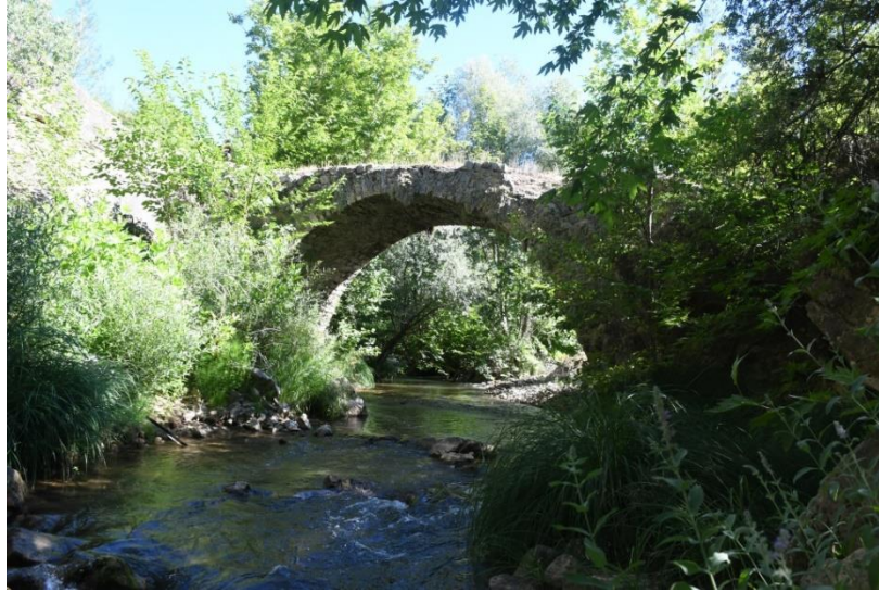
Şekil 2: Himmetli Köprüsü mansap cephesinden genel görünüm
