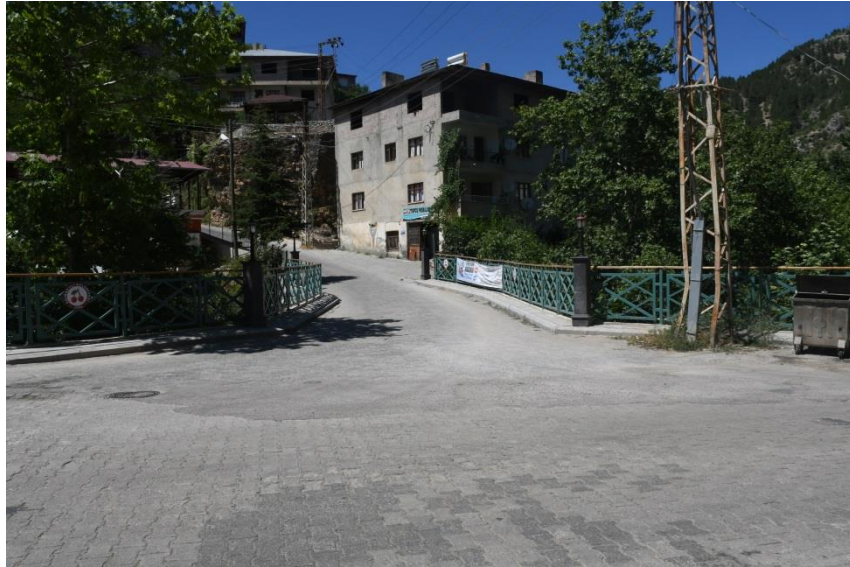
Şekil 5: İslam Mahallesi Taş Köprü genel görünüm
