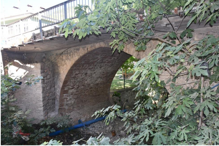
Şekil 3: Fatih Mahallesi Taş Köprüsü mansap cephesinden görünüm
