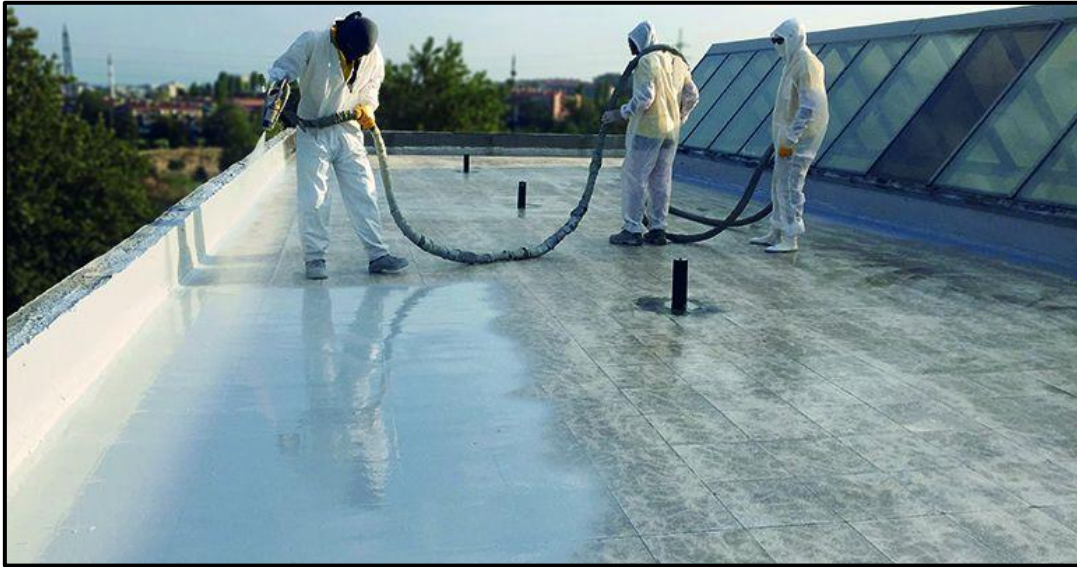
Şekil 12. Su yalıtım uygulaması (Web-6, 2023)
