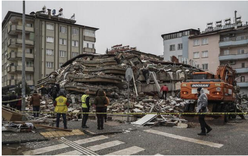
Şekil 1. Gaziantep (Türkiye) Depremden Sonra Yıkılmış Bir Bina ( https://www.timesofisrael.com/unesco-sounds-alarm-over-earthquake-damage-to-turkey-syria-heritage-sites/ )
