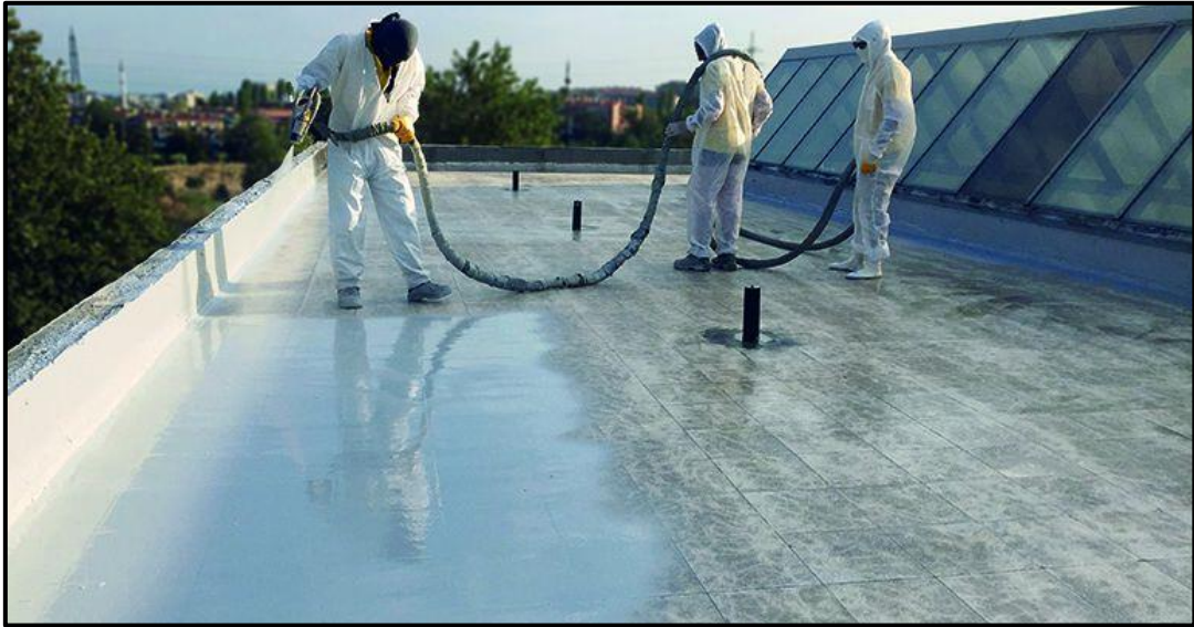
Şekil 12. Su yalıtım uygulaması (Web-6, 2023)
