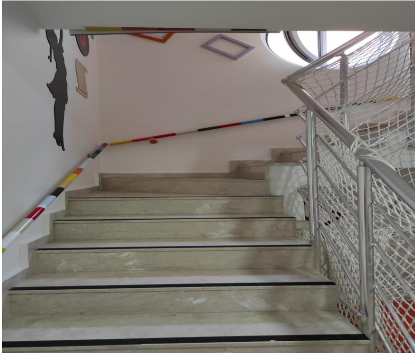
Resim3: Kütüphane Binasında Bulunan Merdivenler
