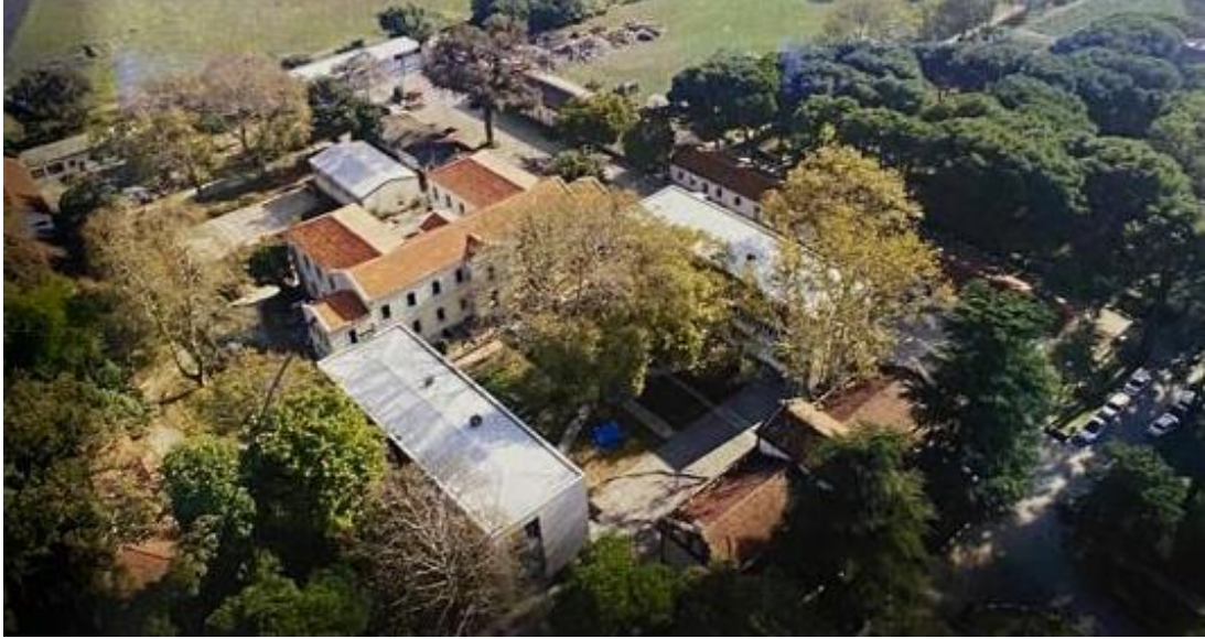
Şekil 14 Yerleşkeyi gösteren hava fotoğrafı (Bursa Koruma Bölge Kurulu Arşivi, 2023)
