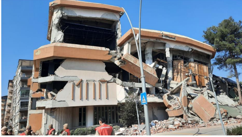
Şekil 8. Hatay Kültür Merkezi 6 Şubat 2023 depremleri sonrası hasar (TMMOB s.26).
