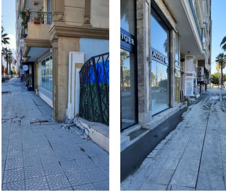
Şekil 11. İskenderun Cengiz Topel Caddesi zeminden aşağı çöken binalar (TMMOB s.29).
