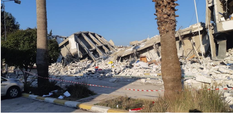
Şekil .5 Deprem sonrası Hatay'dan bir görünüm
