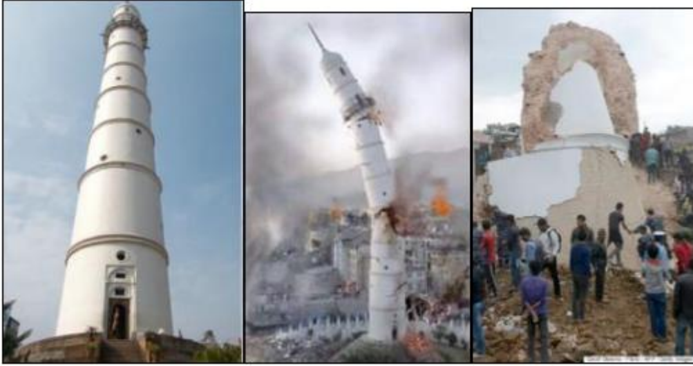
Şekil 15. Deprem sonrası Nepal'deki Dharahara Kulesi Görünümü (Tercan, 2018: s.303)
