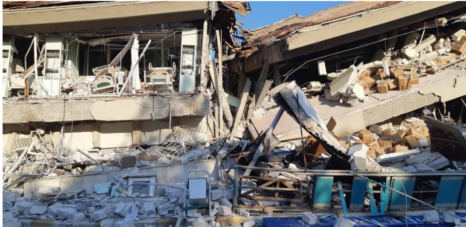
Şekil 4. Deprem sonrası Hatay'dan bir görünüm
