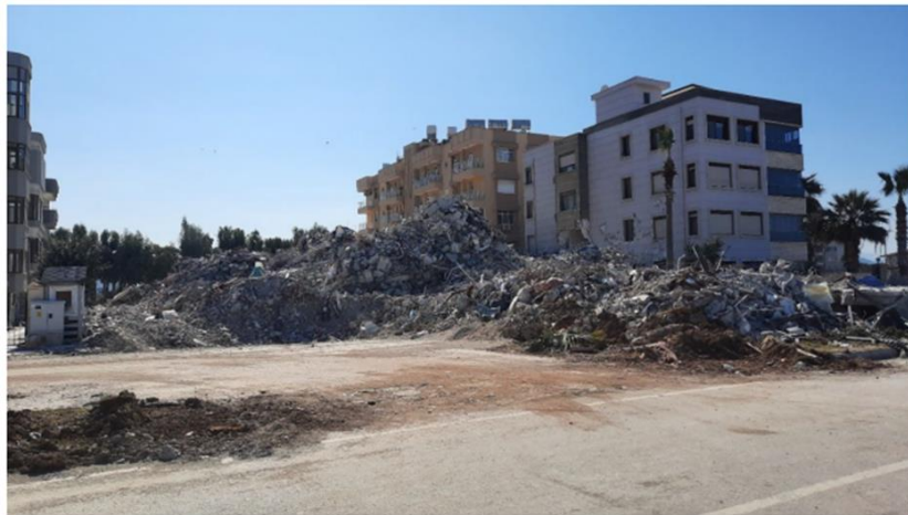
Şekil 13. İskenderun sahil şeridindeki yıkılan yapılar (TMMOB s.30).
