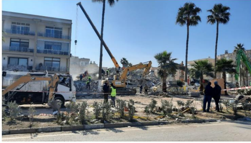
Şekil 12. İskenderun Eda Apartmanı (TMMOB s.30).
