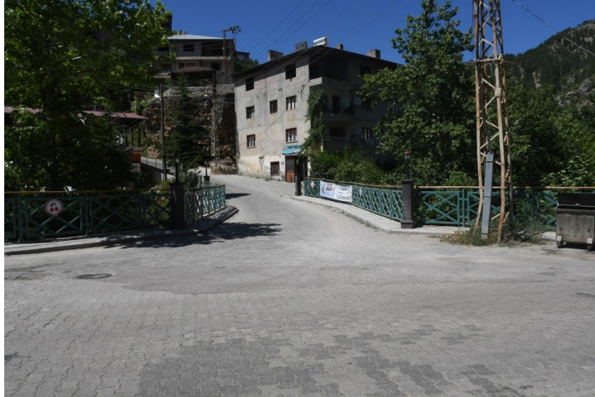
Şekil 5: İslam Mahallesi Taş Köprü genel görünüm
