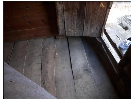
Foto.25, 26 : Çorum İskilip Aşağı Şeybler Köyündeki Ahşap Türbelerde Zemin Duvar İlişkisi (25) ve Döşeme Kaplamaları (26)
