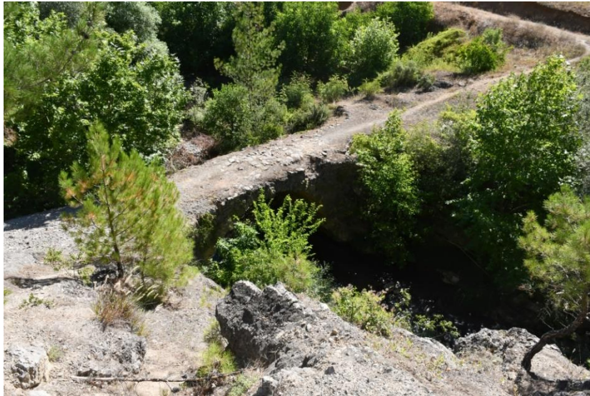
Şekil 1: Himmetli Köprüsü genel görünüm
