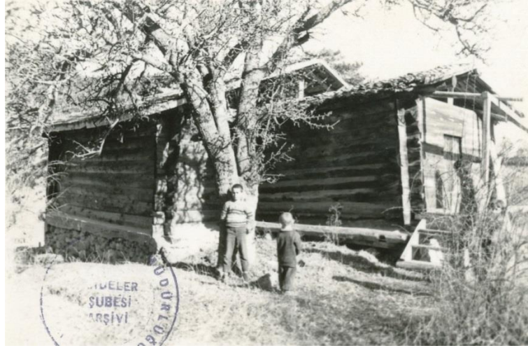
Foto.22 : Çorum İskilip Dereseği Köyünün Evlik Mahallesiindeki (Mezrasındaki) Türbelerin 1994 Öncesi Durumları, Kuzeybatı Cepheler.
