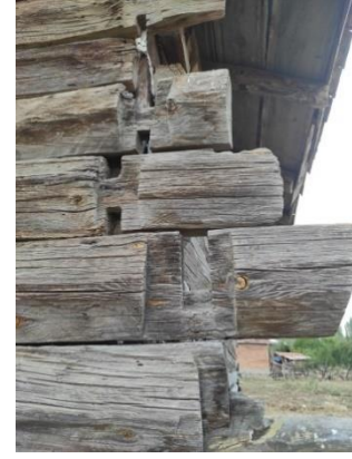
Foto.18, 19 : Çorum İskilip Dereseği Köyün Evlik Mahallesiindeki (Mezrasındaki) Ahşap Akşemseddin Camisi (18) ve İskilip'te Çantı Tekniği Örnekleri (19)
