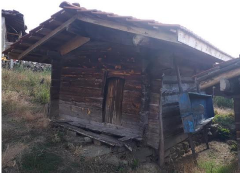
Foto.25, 26 : Çorum İskilip Aşağı Şeybler Köyündeki Ahşap Türbelerde Zemin Duvar İlişkisi (25) ve Döşeme Kaplamaları (26)
