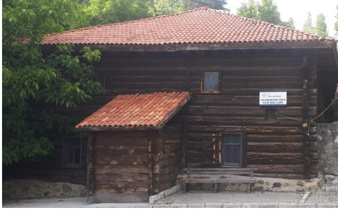
Foto.18, 19 : Çorum İskilip Dereseği Köyün Evlik Mahallesiindeki (Mezrasındaki) Ahşap Akşemseddin Camisi (18) ve İskilip'te Çantı Tekniği Örnekleri (19)
