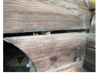
Foto.16, 17 : Çorum İskilip Aşağı Şeybler Köyündeki 5 Ahşap Türbeden iki örnek (16) ve kavelalı (Ahşap çivili) birleştirme (17)
