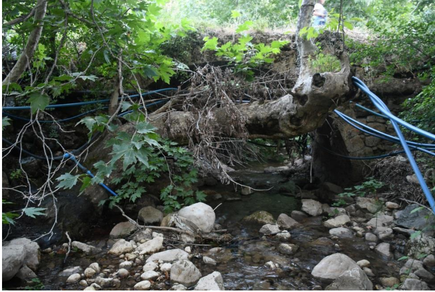
Şekil 8: Obruk Yolu Taş Köprüsü mansap cephesi görünümü
